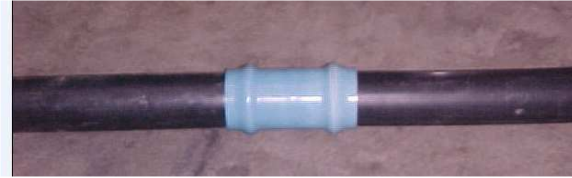
Imagen 6: Unión de ductos de PE realizada con cupla de PVC
