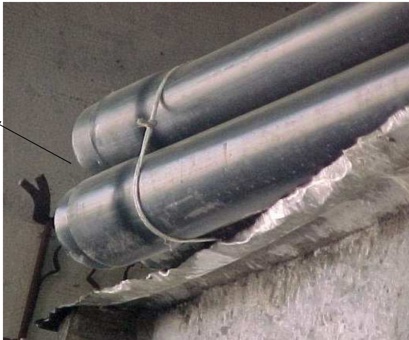
Imagen 1: Extremo “hembra” en ducto de PE.
