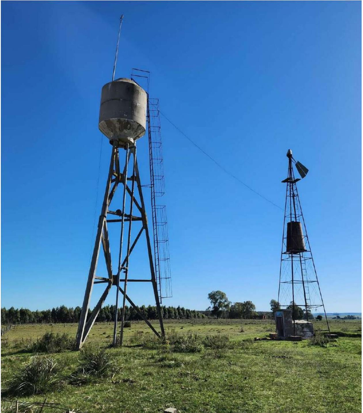
Se realizará desmantelamiento total de la estructura existente del viejo molino, como de las estructuras de hormigón (casamatas existentes), se da limpieza del predio retirando materiales de descarte (mamposterías, hierros, postes, alambres etc.). Debiendo consultar a la administración el destino de cada uno de los elementos.
