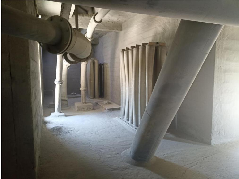
Para el proyecto se retirará uno de los filtros actuales y se instalarán en ese sitio los nuevos. En caso de ser necesaria una descarga puede utilizarse la misma por donde se toma, alguna de las aberturas que actualmente no se utilizan o se puede practicar una nueva.
