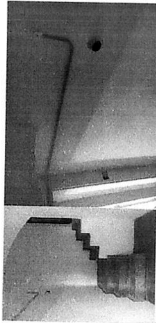
Sustitución de plaquetas. Sustitución de pico de luz por toriuga, verificar su funcionamiento, rehenebrado y encendido/apagado.
