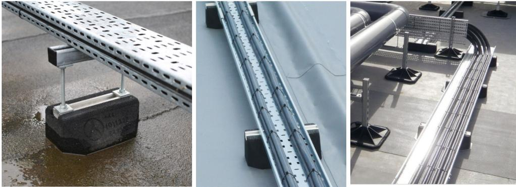
Los ductos que sean necesarios instalar deberán ser asegurados con una base, utilizando tornillería de acero inoxidable AISI 304, cuyos apoyos en la cubierta serán de acuerdo a los siguientes requerimientos:
