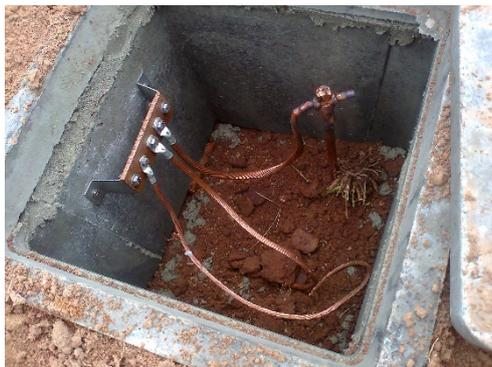
Se instalará una caja con tapa de PVC gris debajo del Rack de Telecomunicaciones. Esta caja deberá contener una bandeja de fondo donde se fijará un riel DIN con una bornera de tierra. A la bornera le llegará un conductor de tierra de  $6\text{mm}^2$ , derivado de la bornera de tierra del TC.
