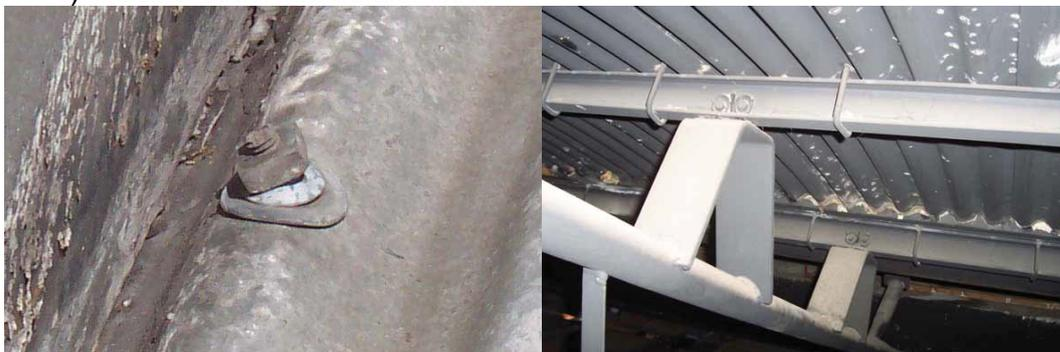
Fotos: bulones ganchos tipo J de fijación de chapas a correas, arandelas y tuerca existentes.
