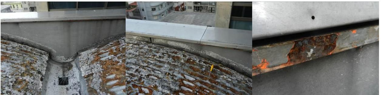
Fotos: imágenes de pretilos y perfil ángulo con corrosión en punto de atornillado de cupertina.
