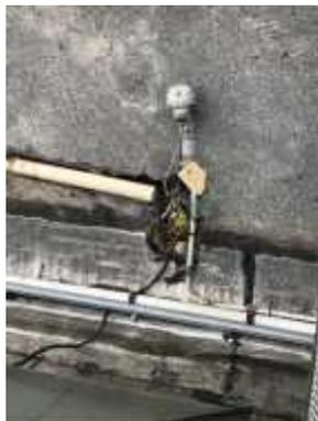
También sobre la medianera Norte, se deberán acondicionar las conexiones existentes de la fotocélula para que queden en el interior de la caja embutida existente.
