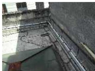
Para el tramo restante se solicita la colocación de grapas omega (o tipo cepo) que permitan la colocación de los caños separándolos de la carpeta asfáltica.
