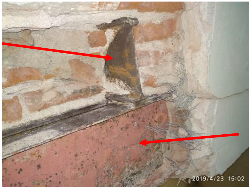
Vista de la Viga V1 apoyada sobre V2, sus estados de conservación y los espesores de revoque existente.
