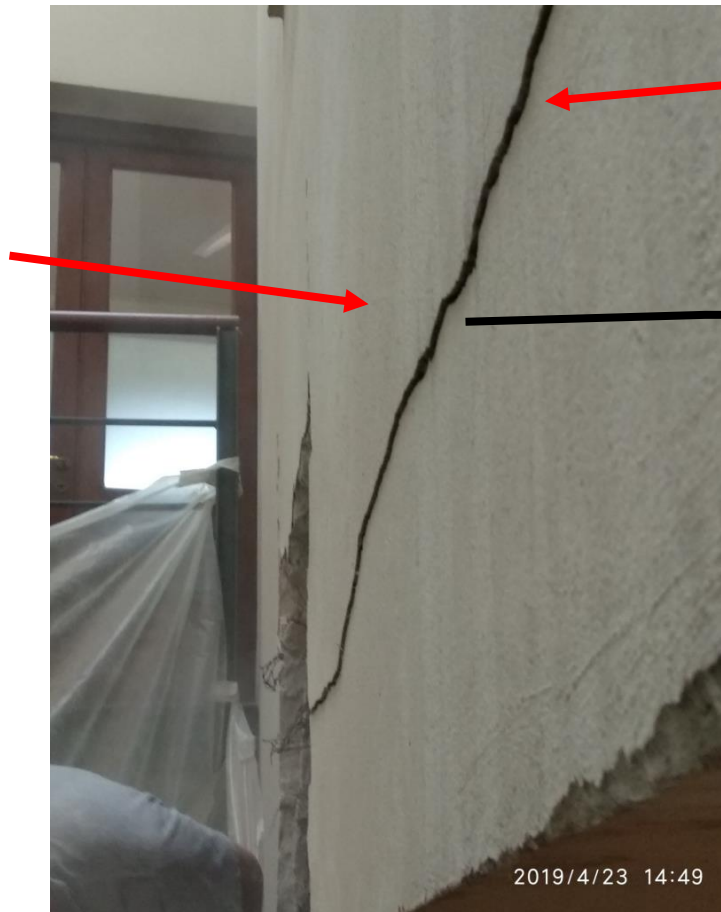
Vista de la Fisura en el muro y la deformación de revoque
