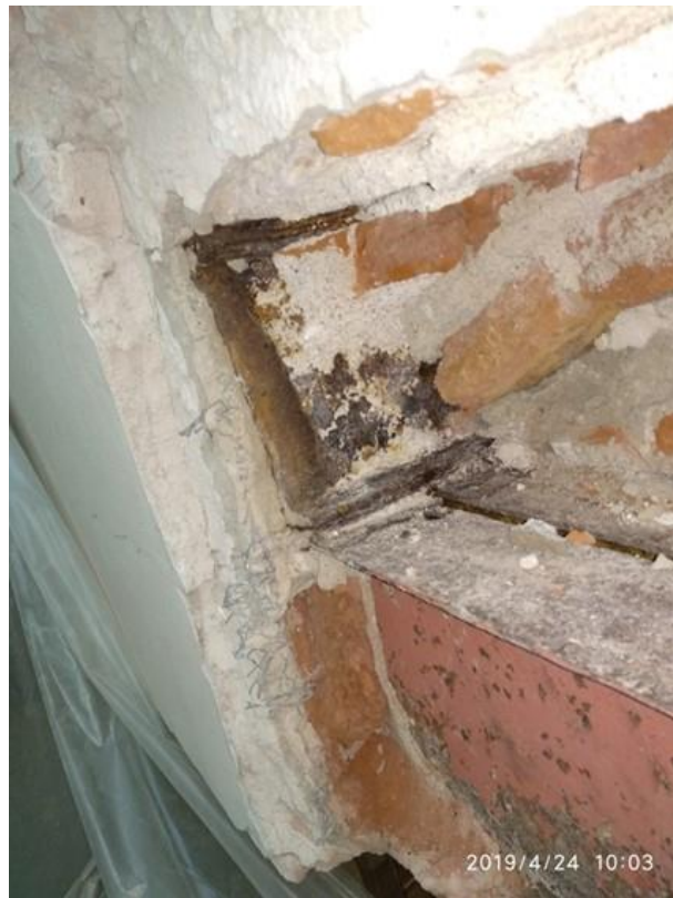
Apoyo de V1 sobre V2, arco cerámico, espesores de revoque.
