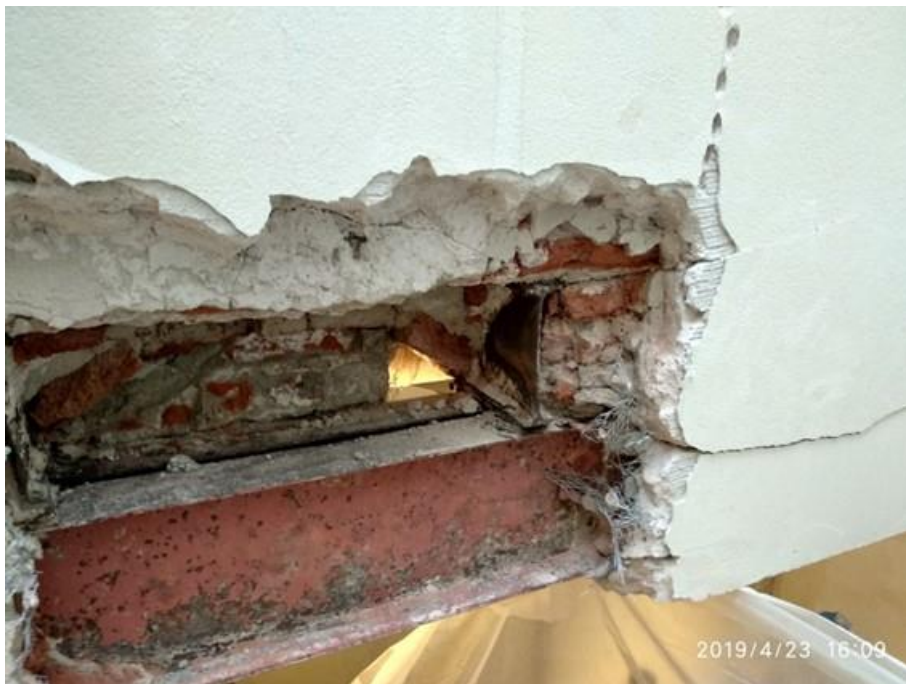
Vista más cercana del cateo, se observa la fisura, V2, V1 apoyada sobre ella y los espesores de revestimiento.
