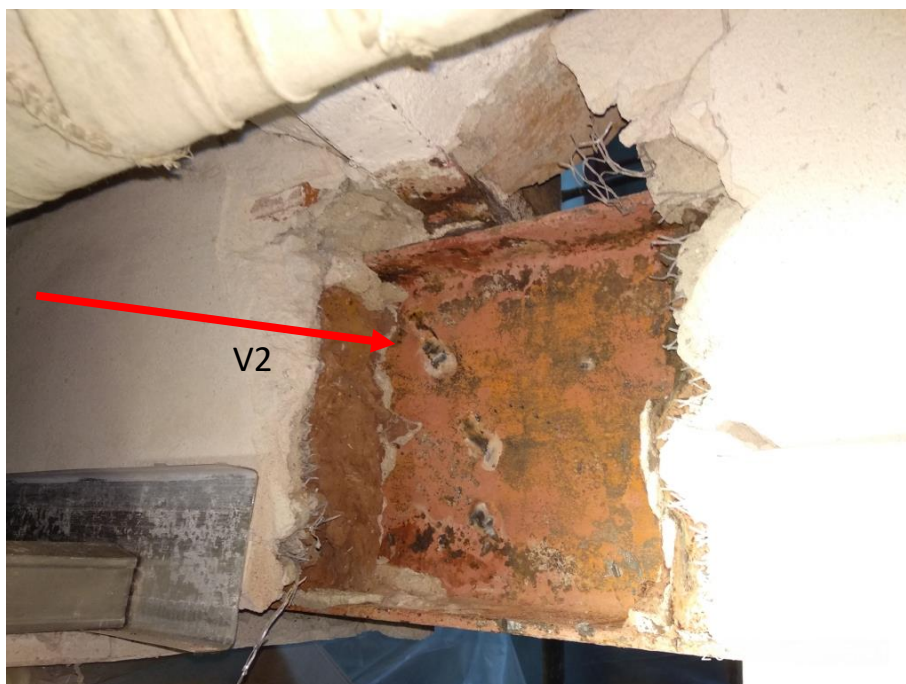
Vista de V2 desde la zona que queda bajo del entrepiso volado de bovedillas, cateo sobre cielorraso de yeso. Se observa el estado de V2.
