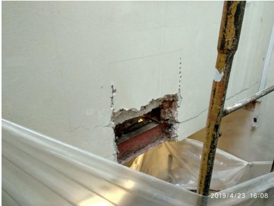
Vista general del cateo, se observa la fisura, V2, V1 apoyada sobre ella y los espesores de revestimiento.
