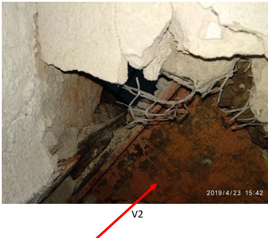
Vistas de V2 desde la zona que queda bajo del entrepiso volado de bovedillas. Se observa el estado de V2, V1, el arco cerámico y el estado del apoyo de V1 sobre V2.
