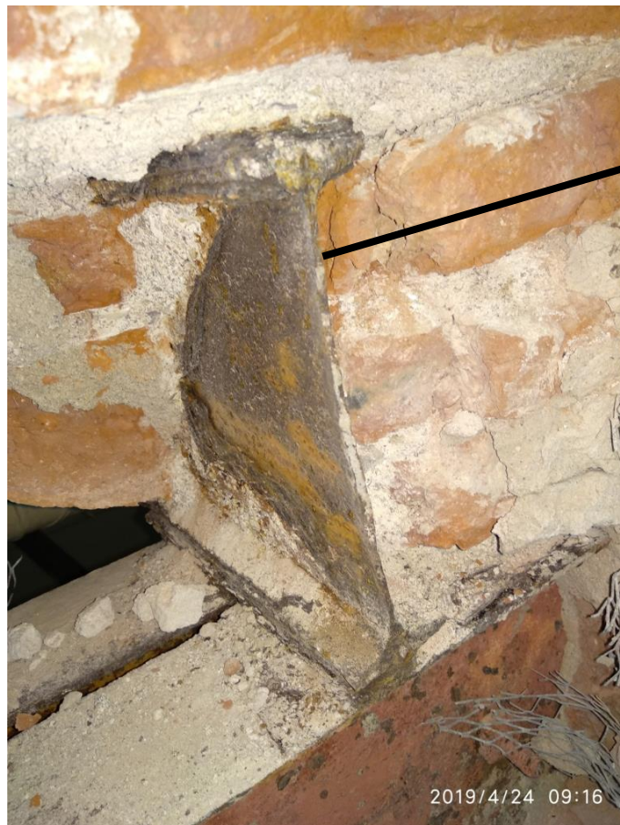
Vista general del cateo, se observa la fisura, V2, V1 apoyada sobre ella y los espesores de revestimiento.
