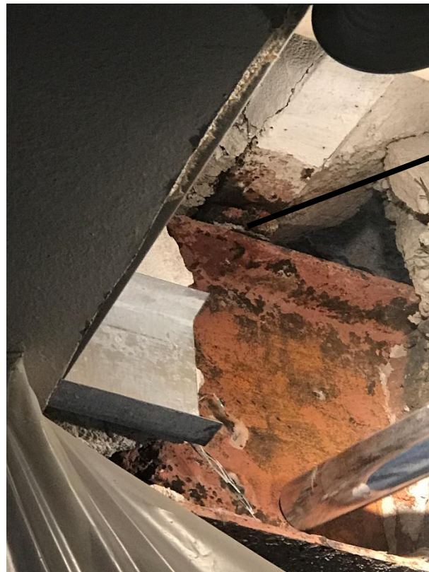
Apoyo de V1 sobre V2, arco cerámico, espesores de revoque.
