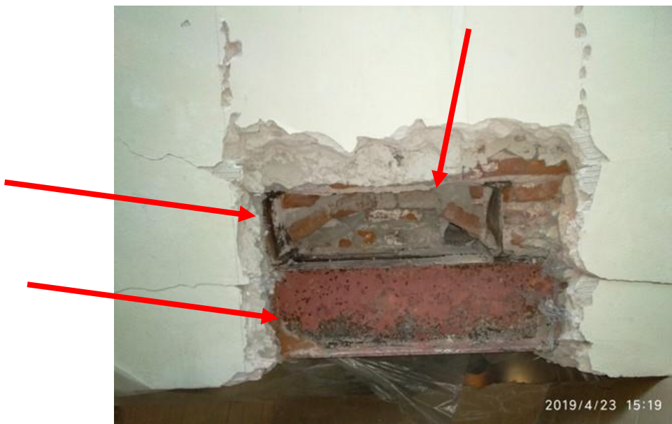
Vista de V1 apoyados sobre V2 y el arco cerámico de la bovedilla.
