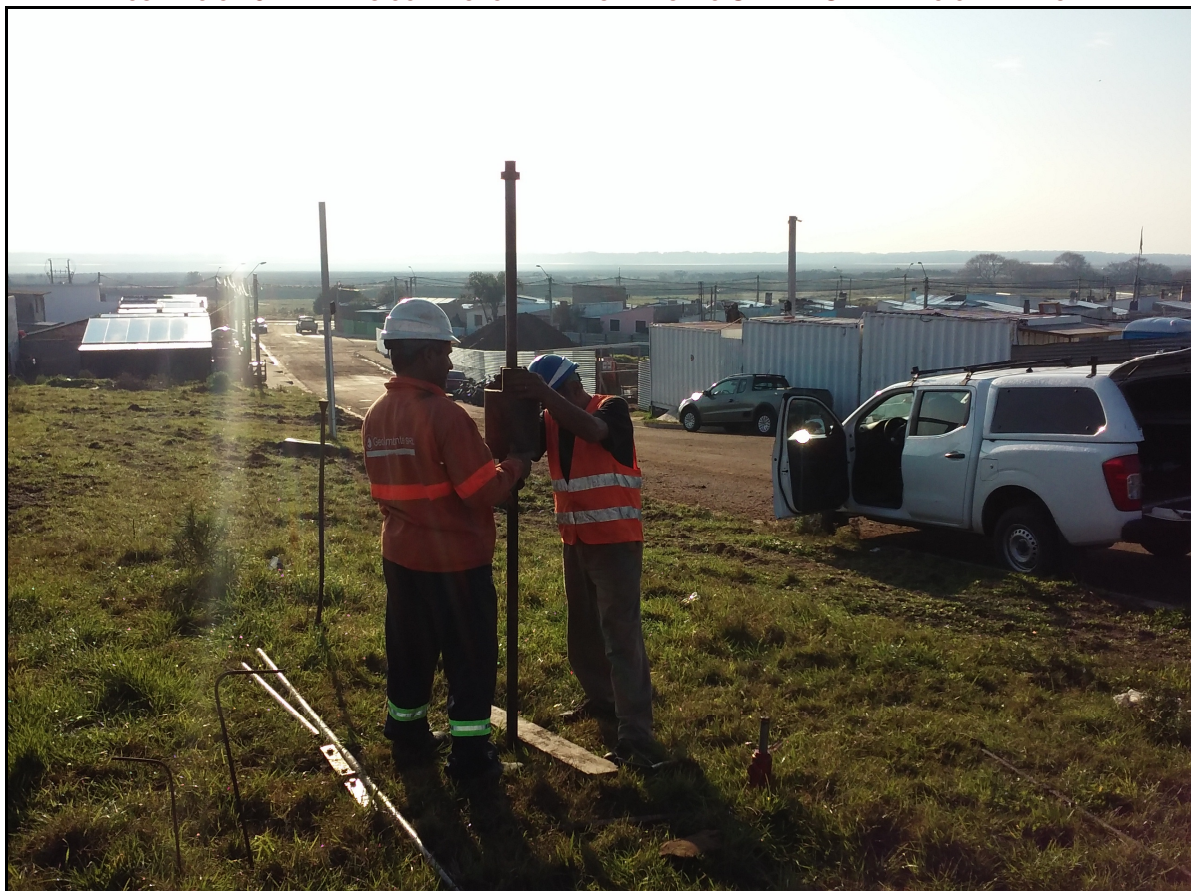
ILUSTRACIÓN 5 – TAREAS CORRESPONDIENTES A ENSAYO SPT EN URBANIZACIÓN DEL ESTE
