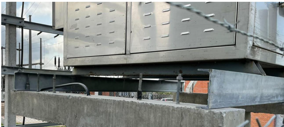
Figura 8 - Resistencia montada sobre perfiles transversales
