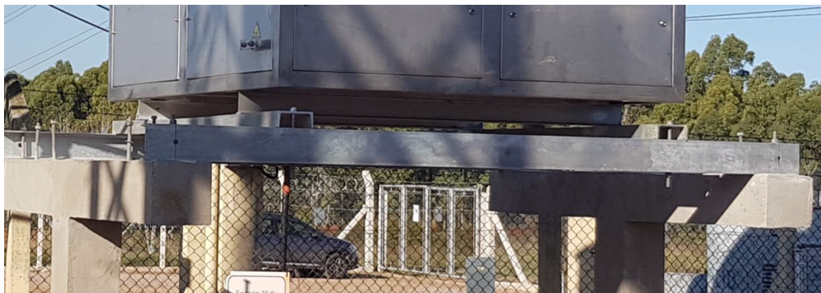
Figura 9 - Montaje de resistencia sobre perfiles transversales, anclados a los perfiles principales
