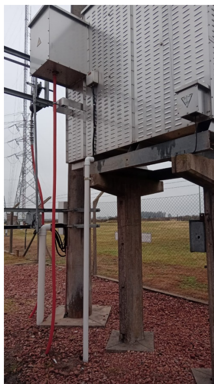
Figura 10 - A la izquierda, aterramiento de los perfiles PNU. A la derecha, bajada de los circuitos de corriente.
