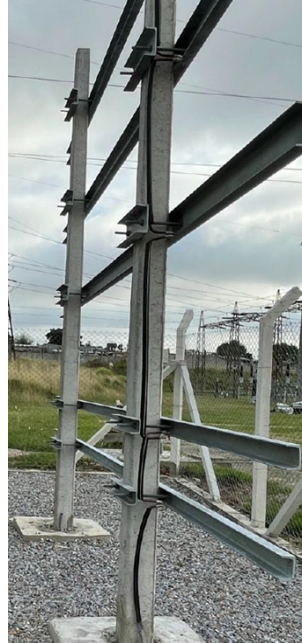
Figura 6 - Columnas con bastidor conformado para el montaje de los seccionadores unipolares y aterramiento de los perfiles
