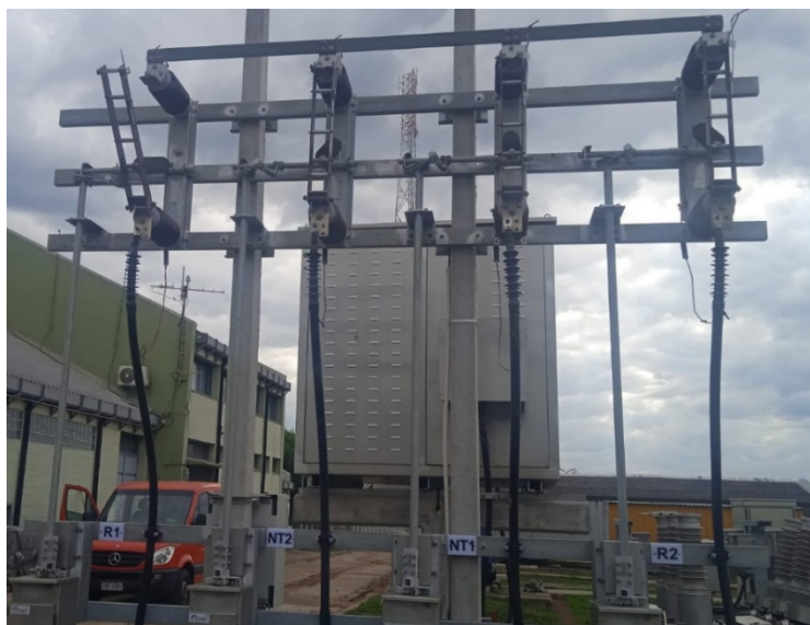
Figura 5 - Bastidor con seccionadores unipolares montados
