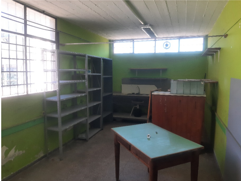
Figura 01. Cantina en su estado actual
