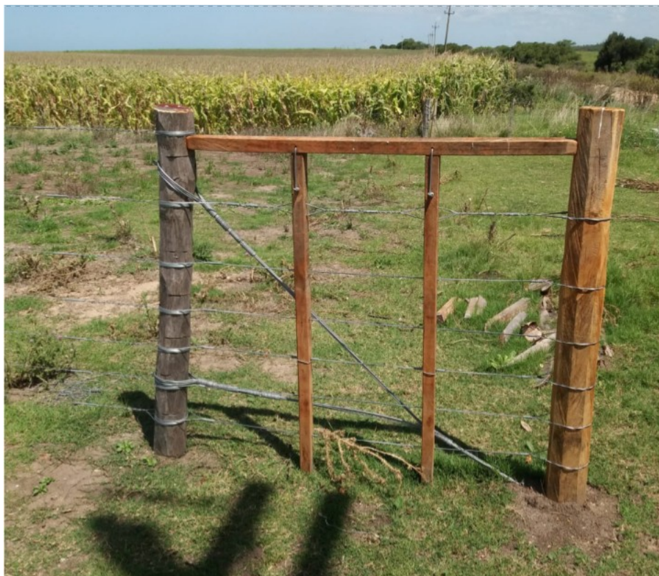
Figura 4. Foto ilustrativa de un arranque (rienda con tramilla)
