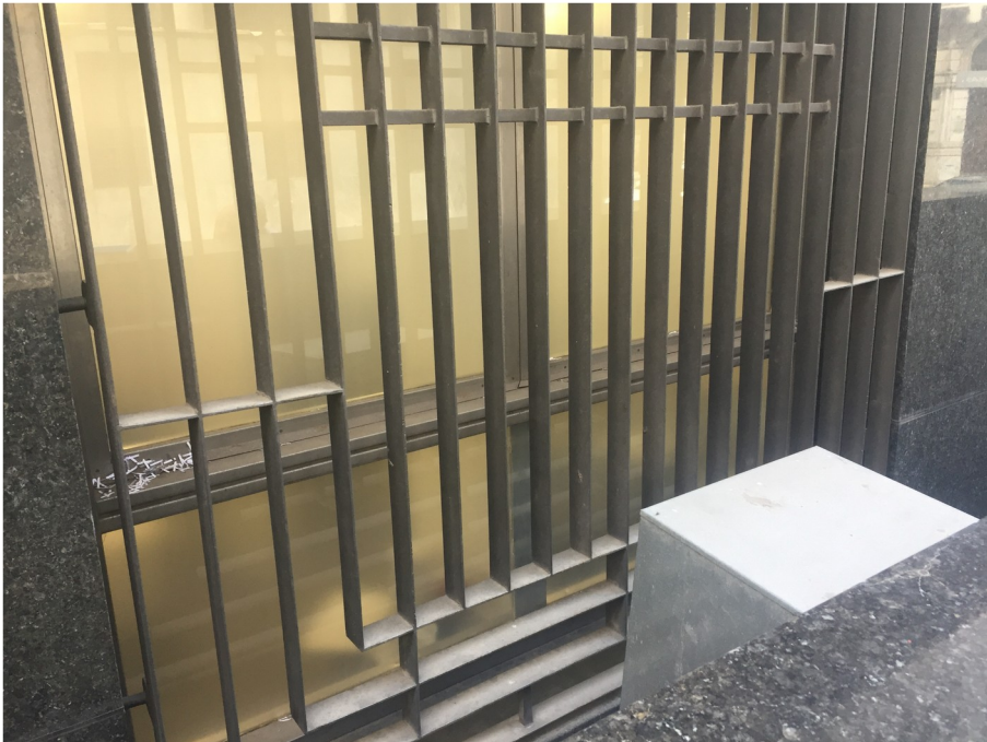
Vista desde el exterior. Paño de vidrio fijo entero con perfil de remate en el interior. Reja fija en el exterior.
