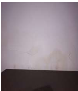
Humedad en muro lindero P. 1270 102
