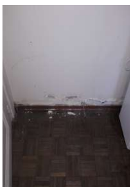
detalle de umbral existente deteriorados se propone contraescalón y reforma de puerta.
