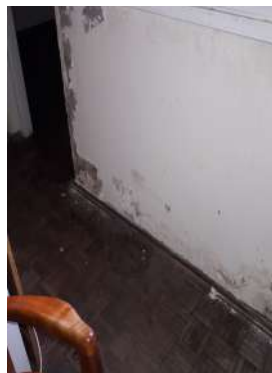
detalle de umbral existente deteriorados se propone contraescalón y reforma de puerta.
