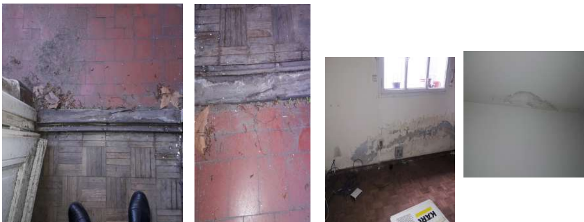
detalle de umbral existente deteriorados se propone contraescalón y reforma de puerta.
