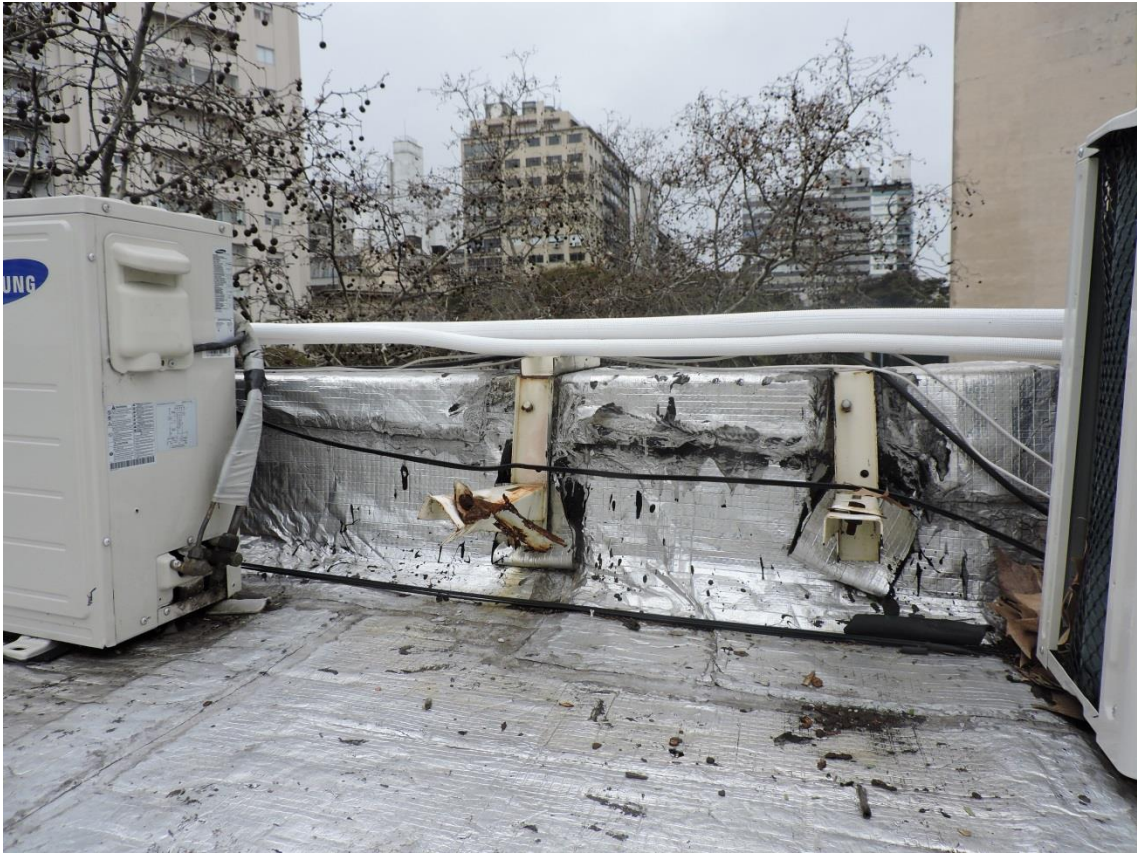
FOTO 6 (sellado de amurado de ménsulas)
