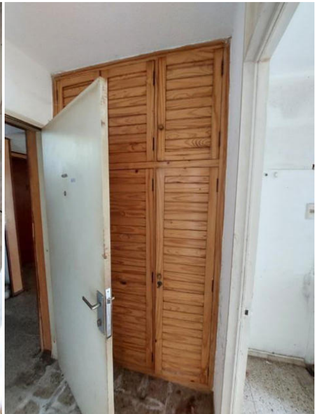
PUERTA DE ACCESO Y PLACARD A CONSERVAR
