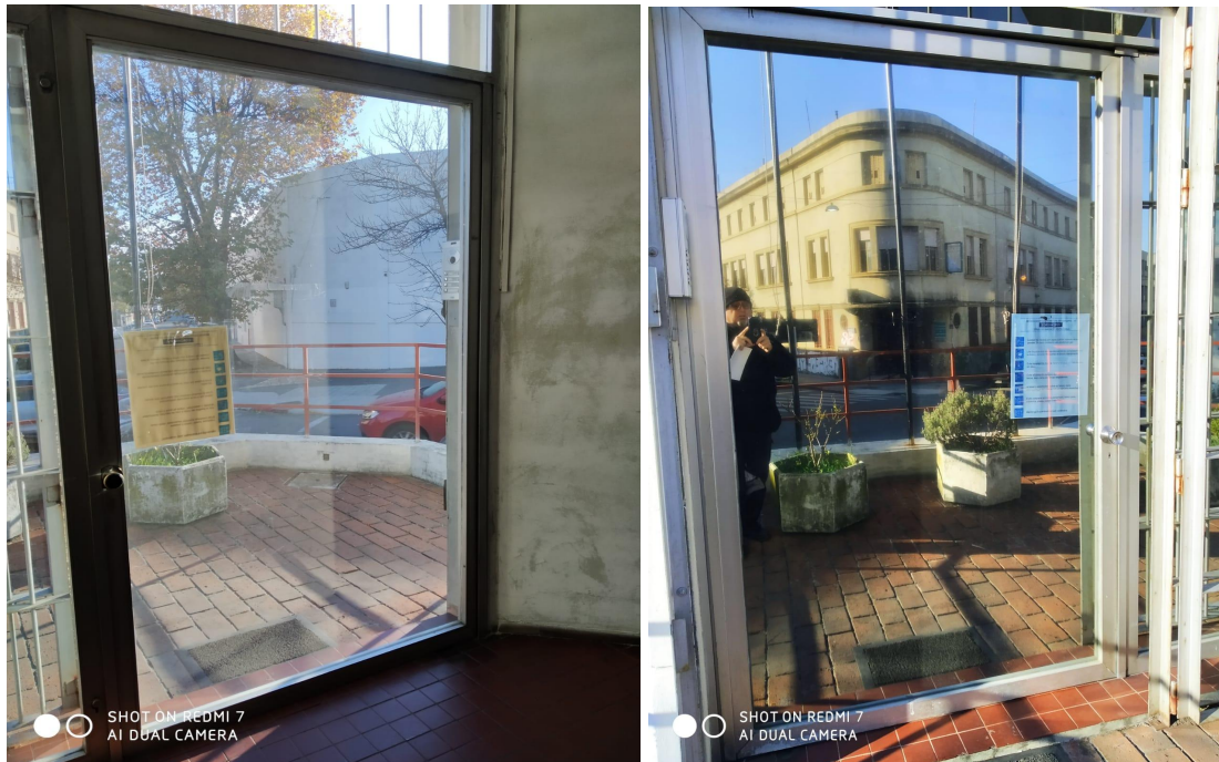
Puerta existente a sustituir.
