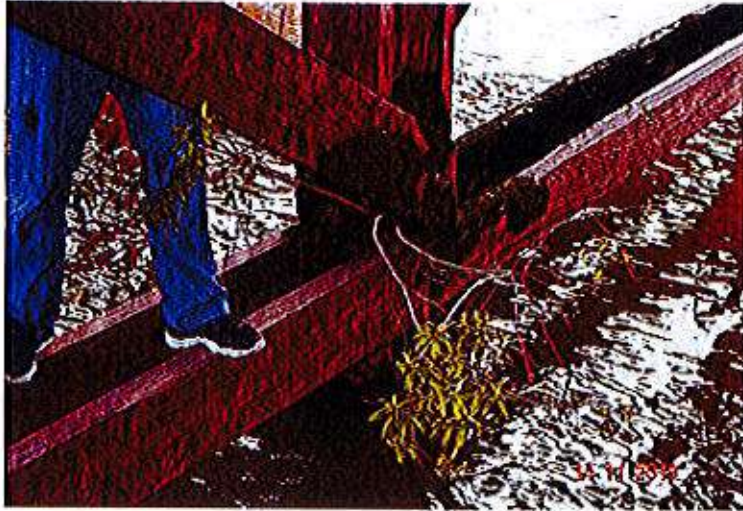
Figura A5. Vegetación en la unión de los elementos.
