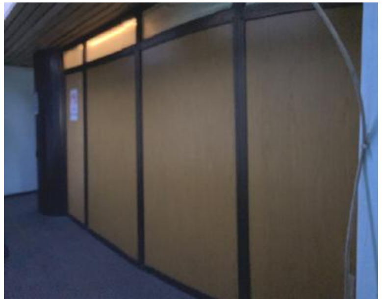
Paneles a intervenir (vista desde baño exterior al Gimnasio). ↑
