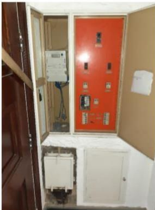
Foto tomada el día 27/7/2021 en la visita de Obra
