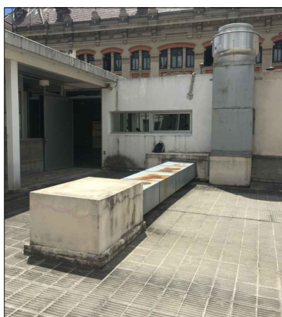
FOTOS DEL SECTOR A INTERVENIR
