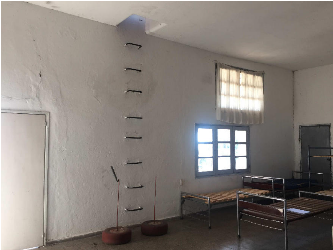
Escalera a pintar y hueco en losa superior.
