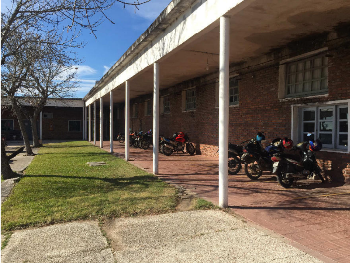
Fachada del área de intervención.
