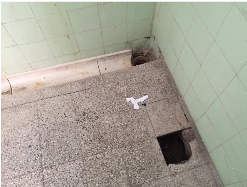
Canal de desagüe existente.
