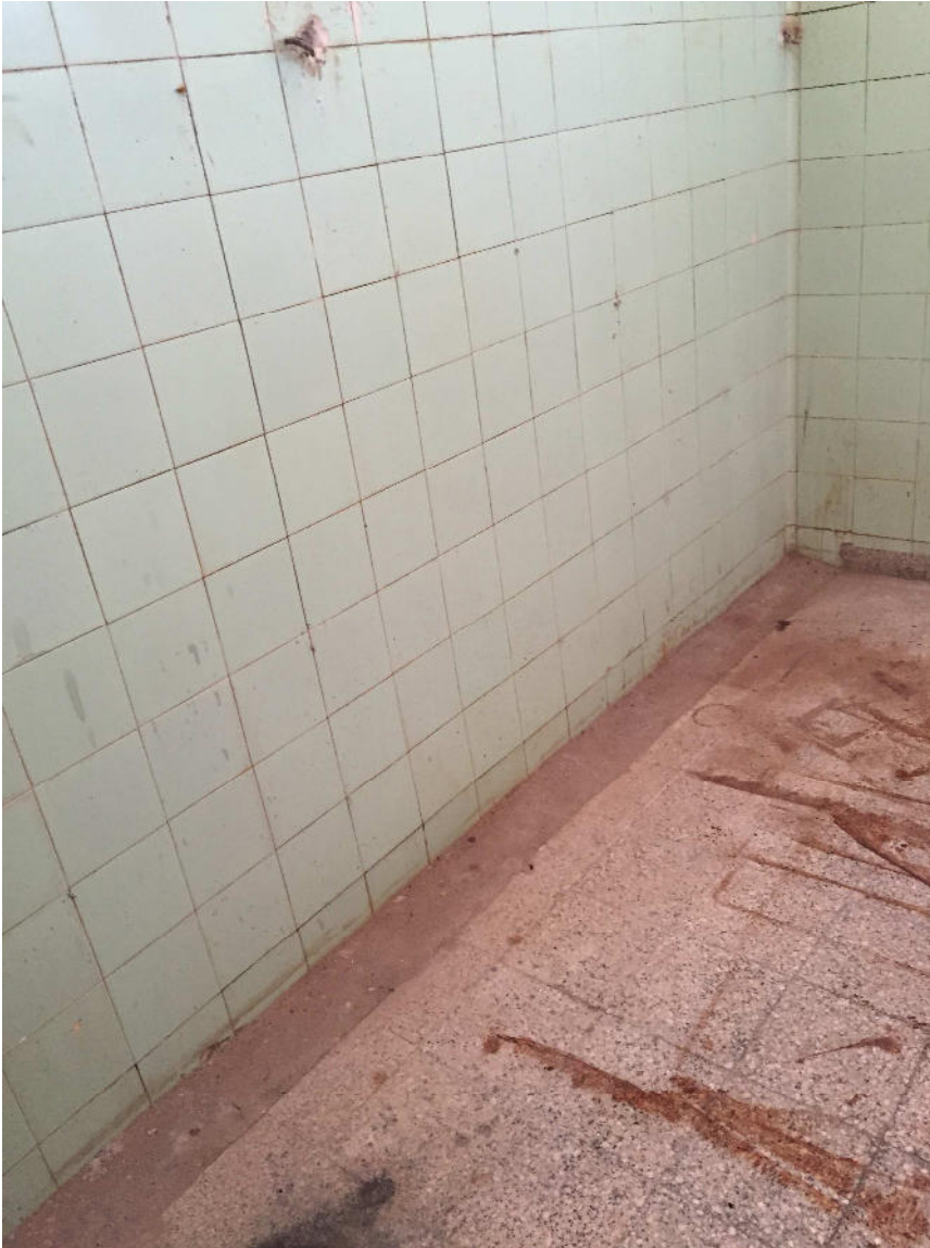
Canal de desagüe a recuperar.
