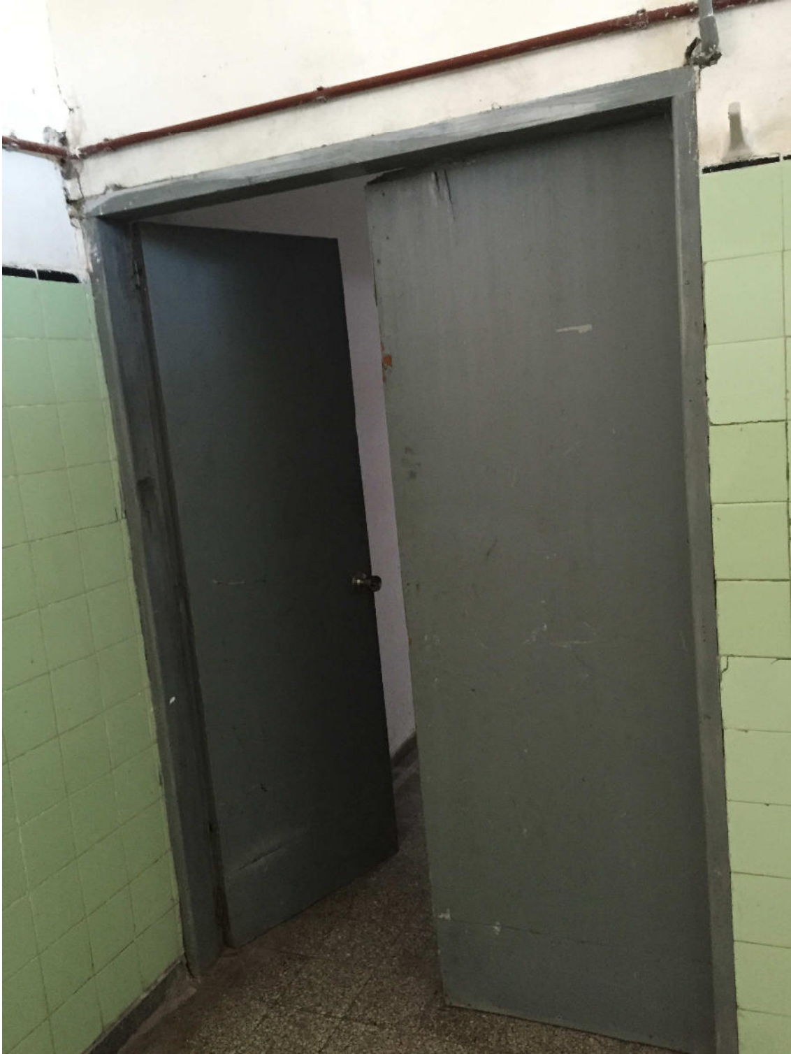
Puerta de ingreso al baño a retirar.
