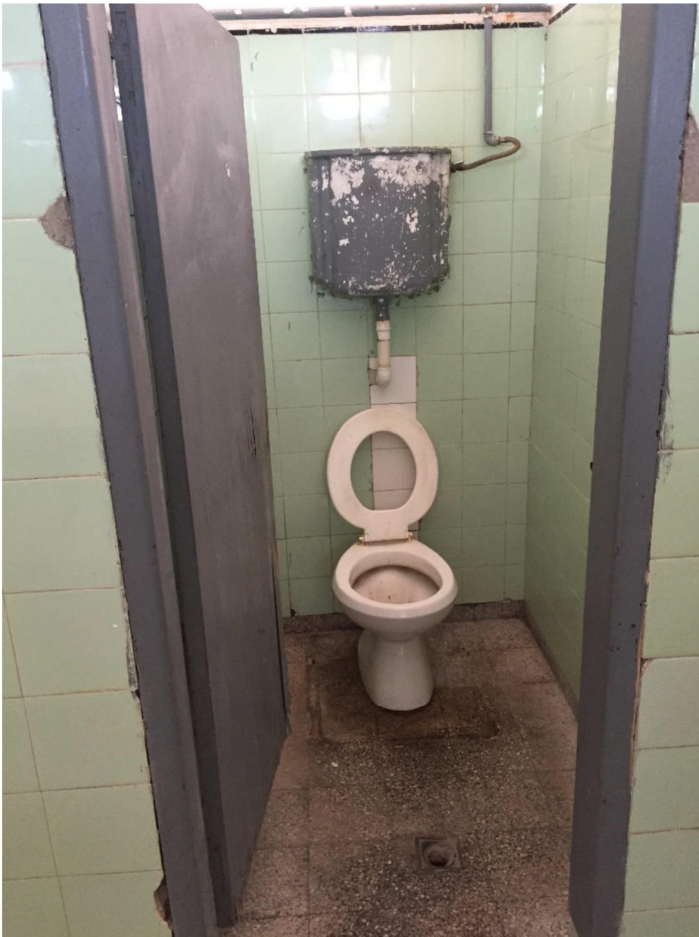
Inodoro existente y cisterna a remplazar.
