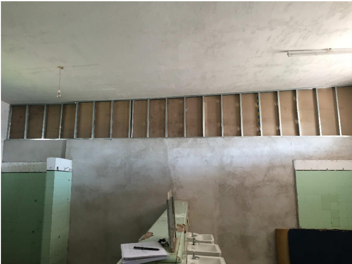
Sector a emplacar y superficie de muro a revestir.
