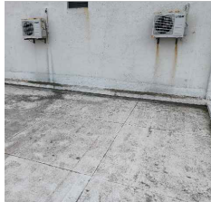
Vista azotea de 4°Piso sector de splits e ingreso de filtraciones
