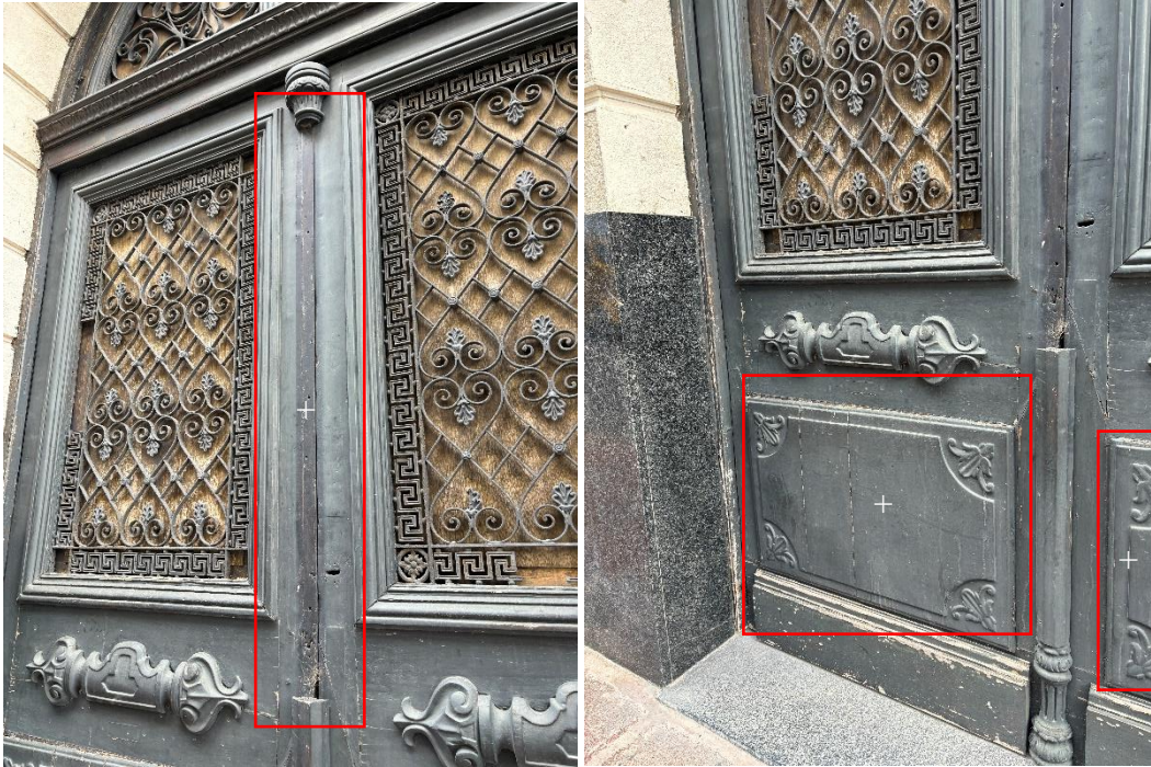
Vista exterior puerta C014
