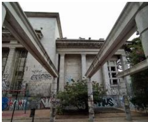
IMG 03. Fachada lateral (sector retirado).
