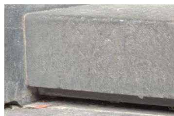
IMG 12. Separación entre huella y contrahuella del escalón siguiente dentro de la buña.
