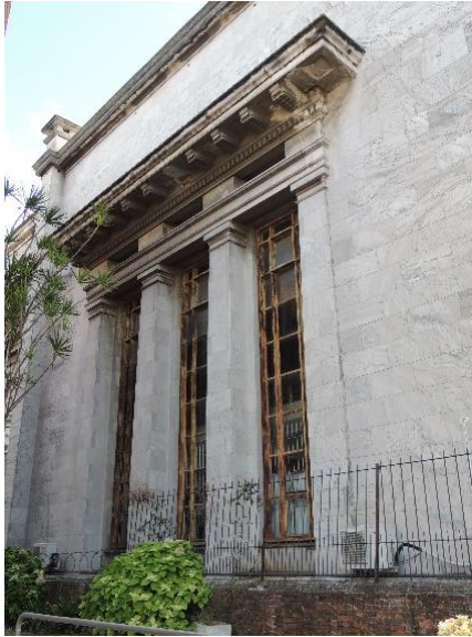
IMG 04. Sector de fachada posterior.
