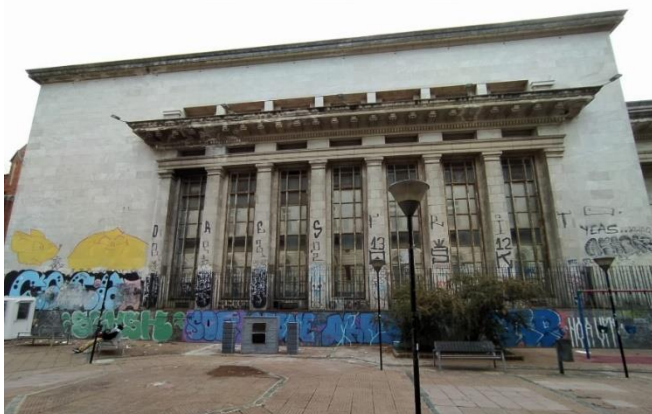
IMG 02. Fachada lateral (peatonal Dr. Emilio Frugoni).
