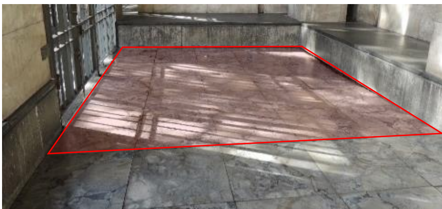
IMG 12. Sector de pavimento a nivelar y restituir.
