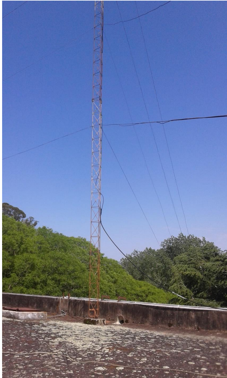
Foto N°1 – Vista de la antena a retirar
