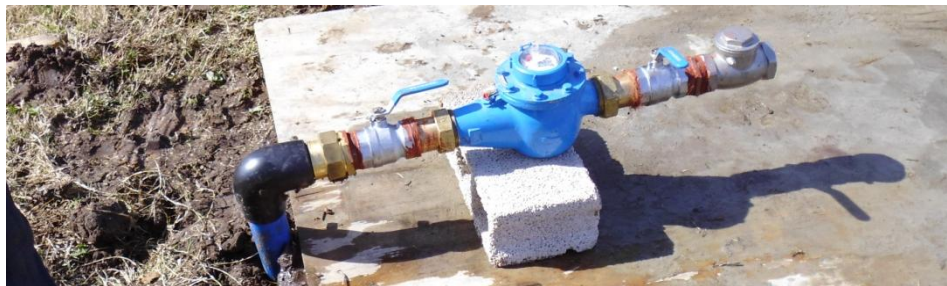
Conexión con medidor roscado de 1 ½ “ y 2”
