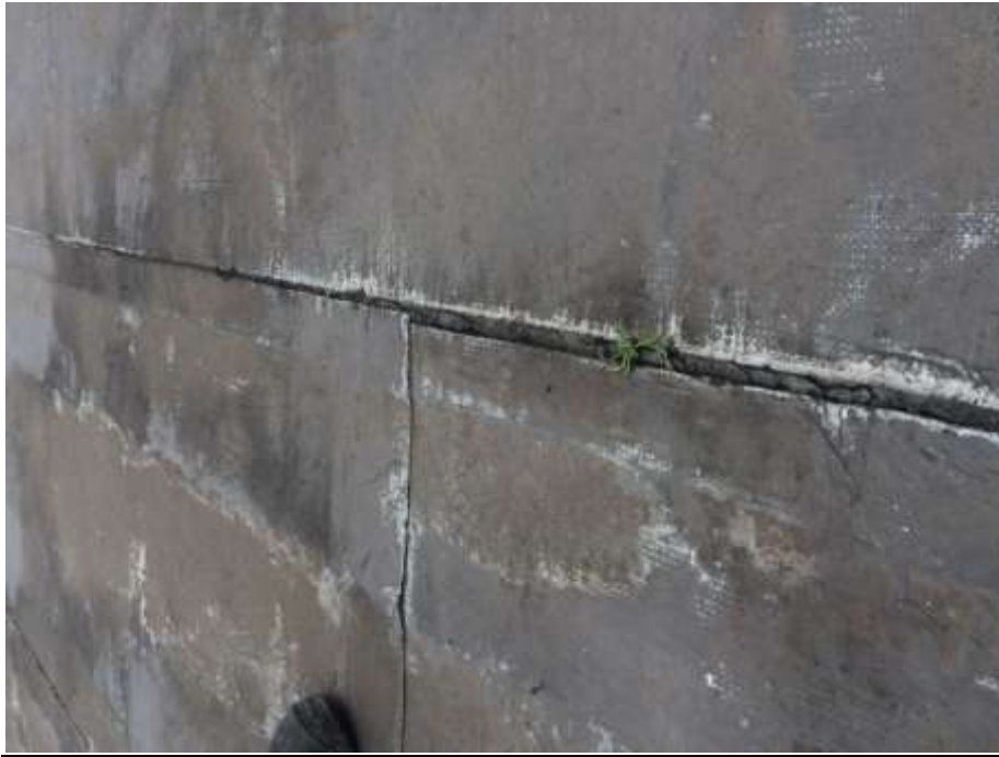
DES-SOLAPE DE MEMBRANA
