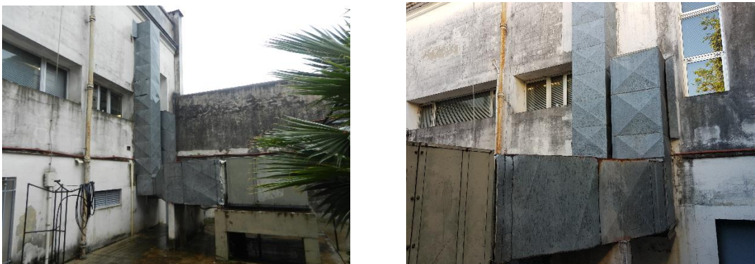
Rooftop a dismantelar, ductos a realizar nuevos
