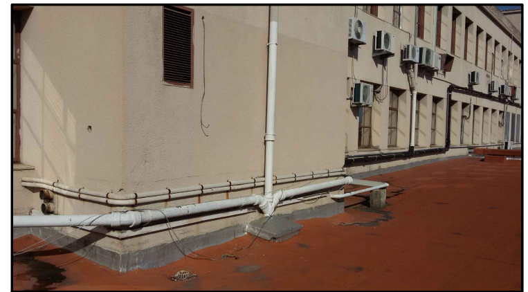
CUARTO PISO POSTERIOR
