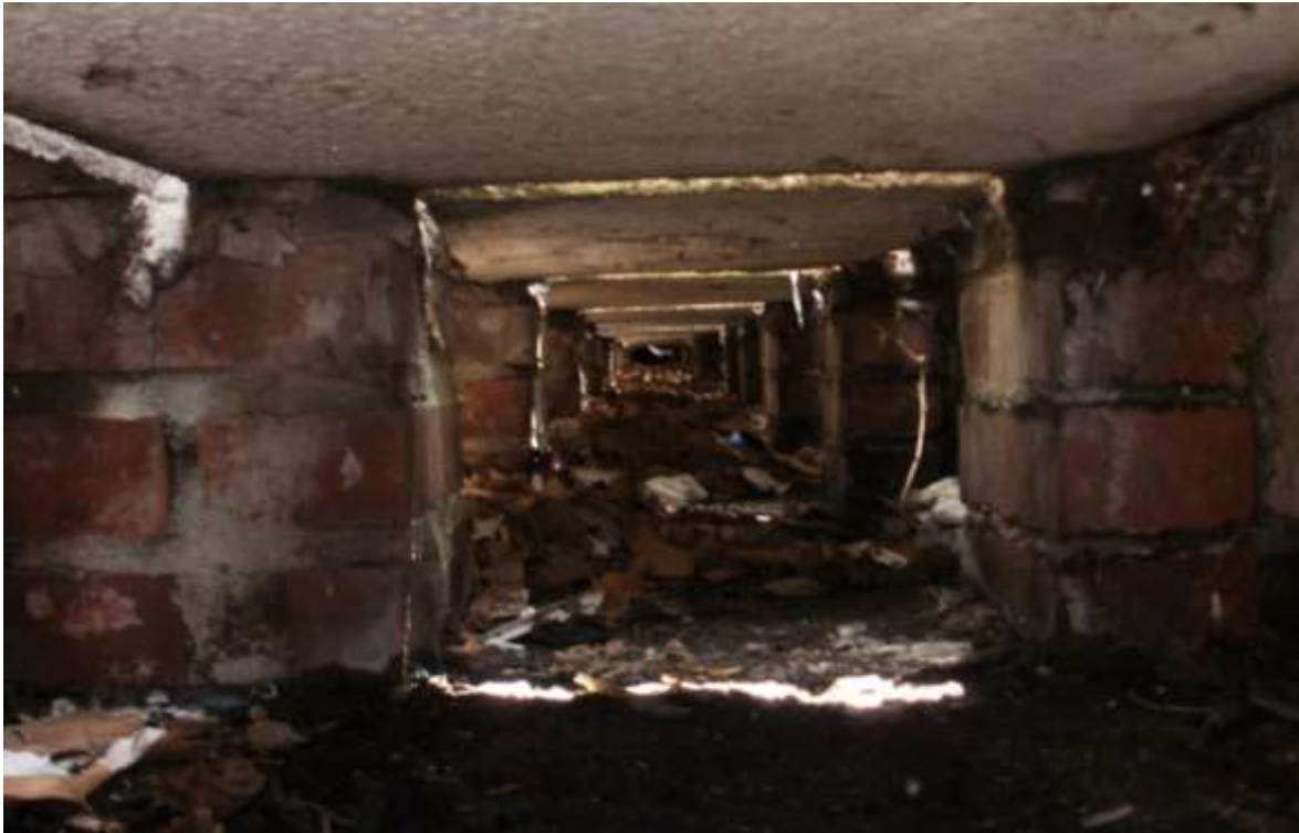
Pilastras de ladrillo bajo empalomado
