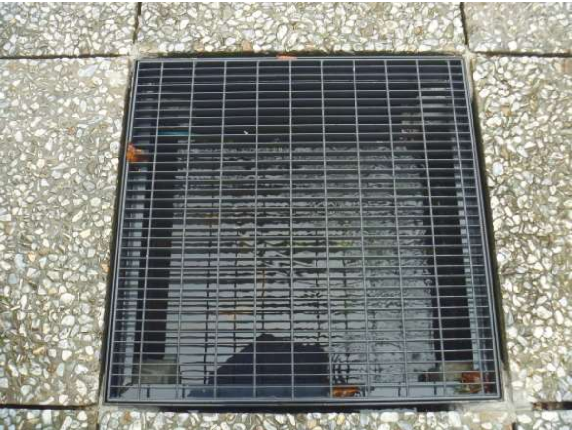
Rejillas colocadas sobre desagües pluviales
