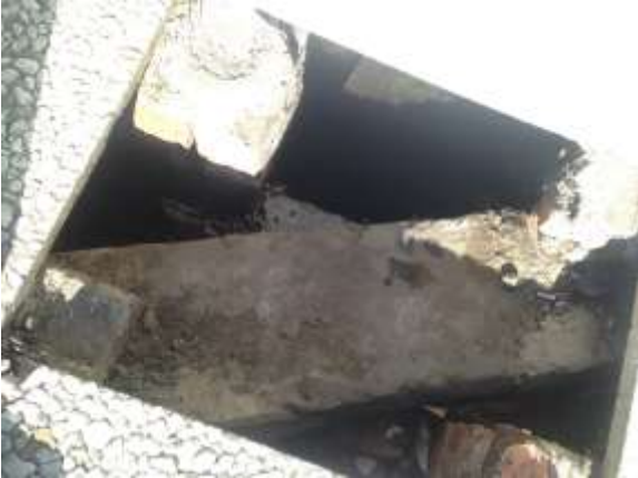
Junta de Dilatación bajo Empalomado
