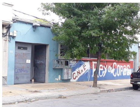
Fachada calle Urquiza
