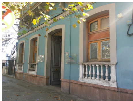
Fachada Av. 8 de Octubre
