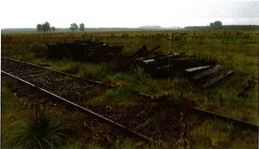
ACOPIO EN BRIGADAS CIVILES (km 511)
