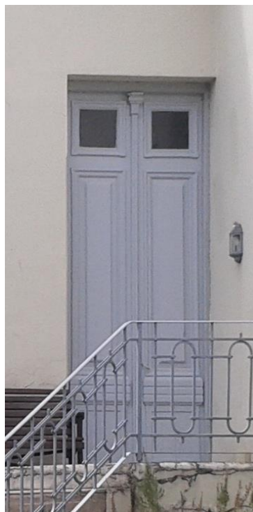
Puerta acceso vivienda de gerente
