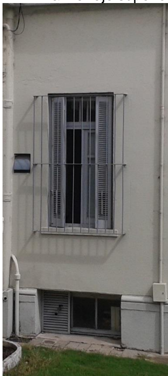
Ventana existente a transformar
