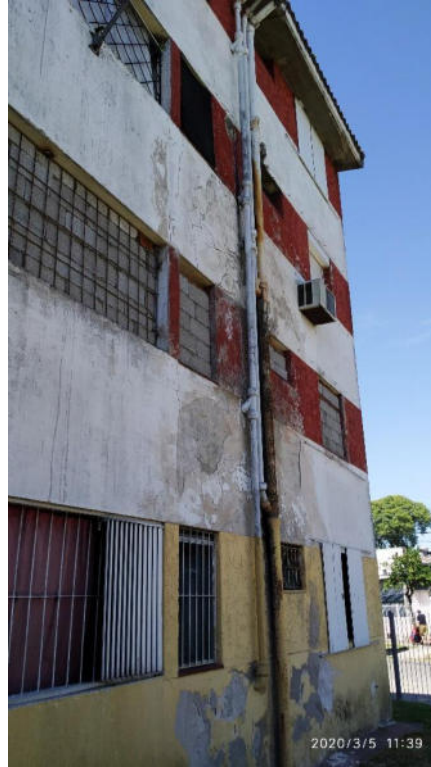
FACHADA A CALLE VIDAURRETA
