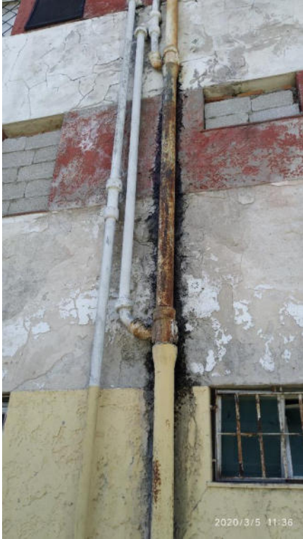
FACHADA A CALLE VIDAURRETA
