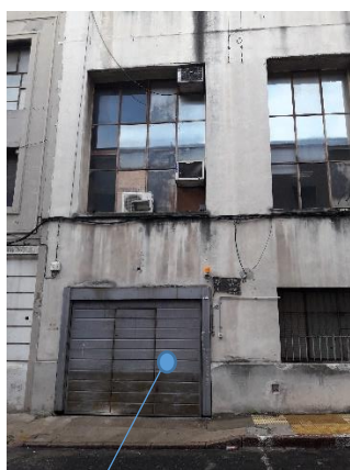
Acceso vehicular al Garage
