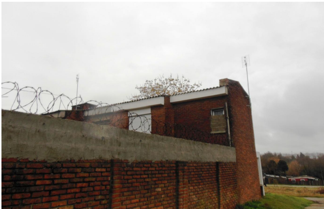
ID. 111705 - 20180801 - foto 2. fachada posterior.
