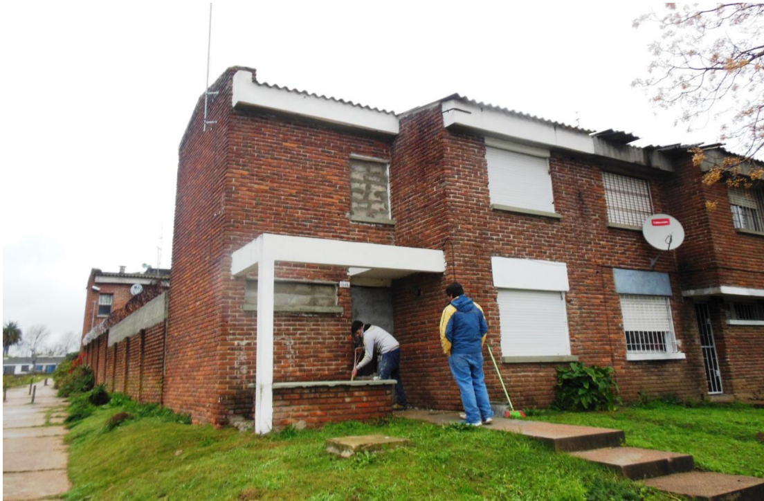
ID. 111705 - 20180801 - foto 1. fachada - acceso.
