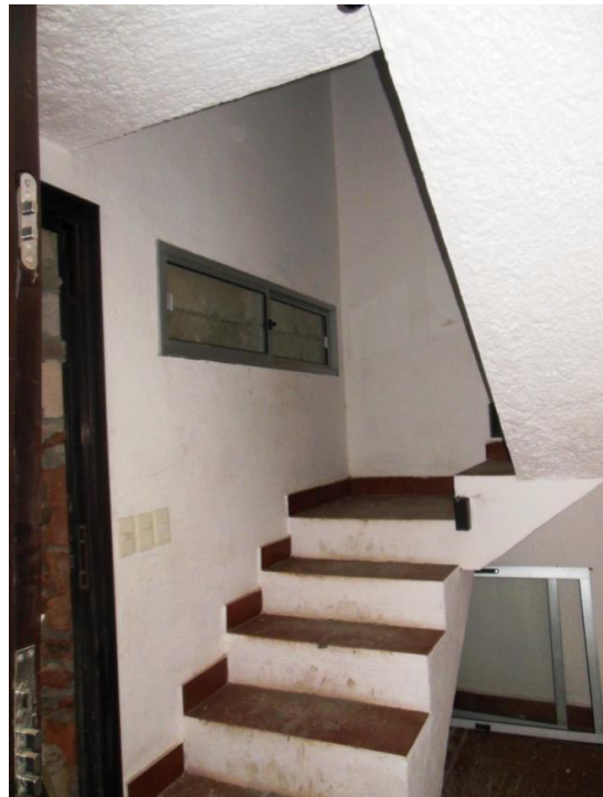
ID. 111705 - 20180801 - foto 4. Acceso vivienda-Escalera
