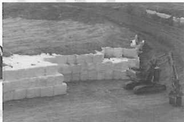
Figura 2-5: Relleno de fardos 5
