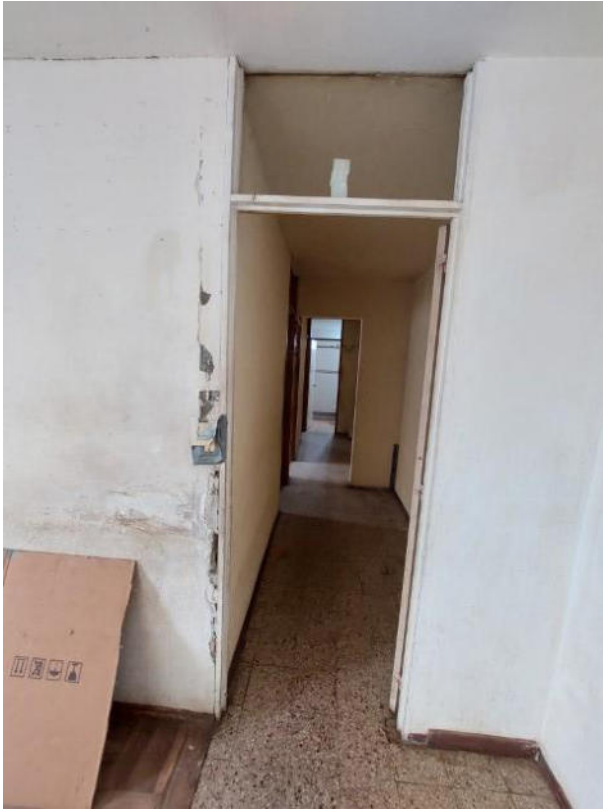
PUERTA A CORREDOR
