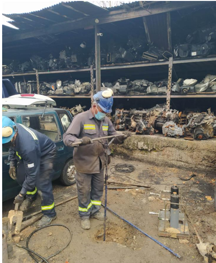
ILUSTRACIÓN 3 –TAREAS CORRESPONDIENTES A LA REALIZACIÓN DEL CATEO P2
