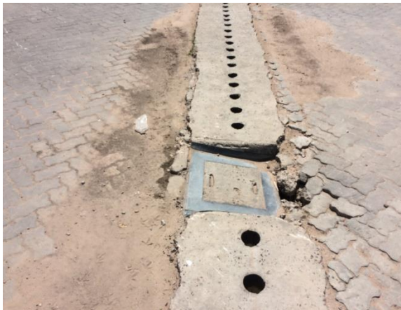
Canalón de desagüe / Reguera
