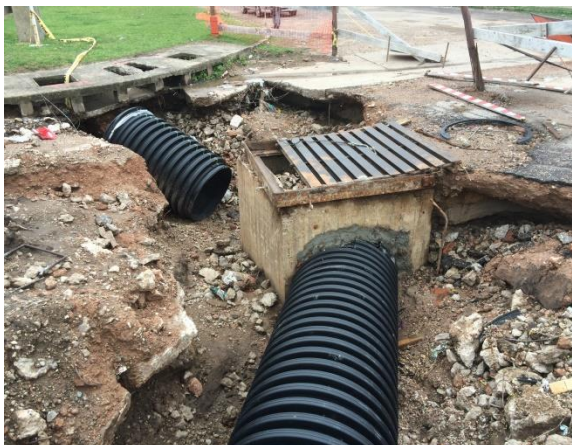
Reacondicionamiento de cámara pluvial dañada por calle L. Gómez en acceso al predio
