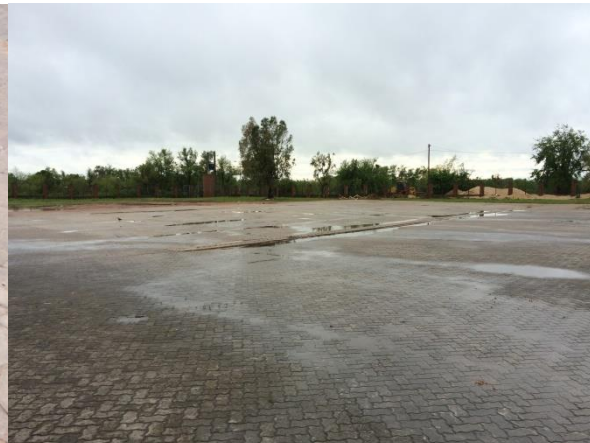
Explanada sur y canalón de desagüe central
