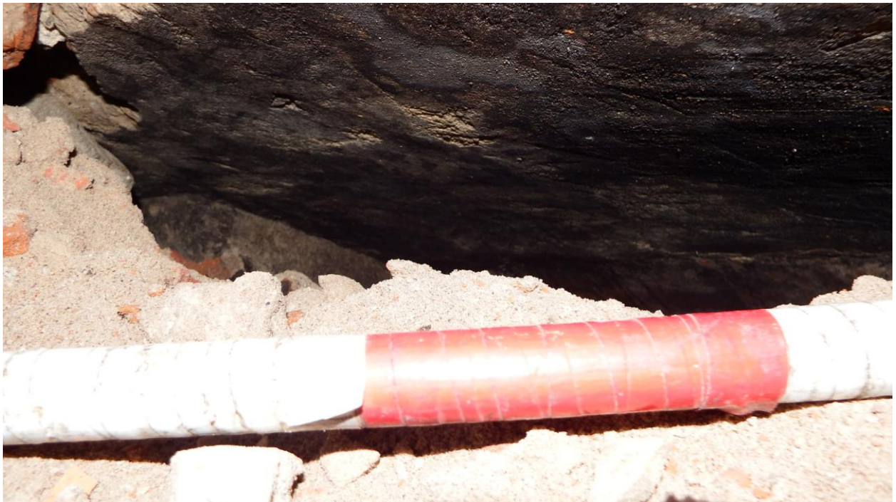
Figura 46. Sondeo 7. Detalle del interior de la cúpula.
