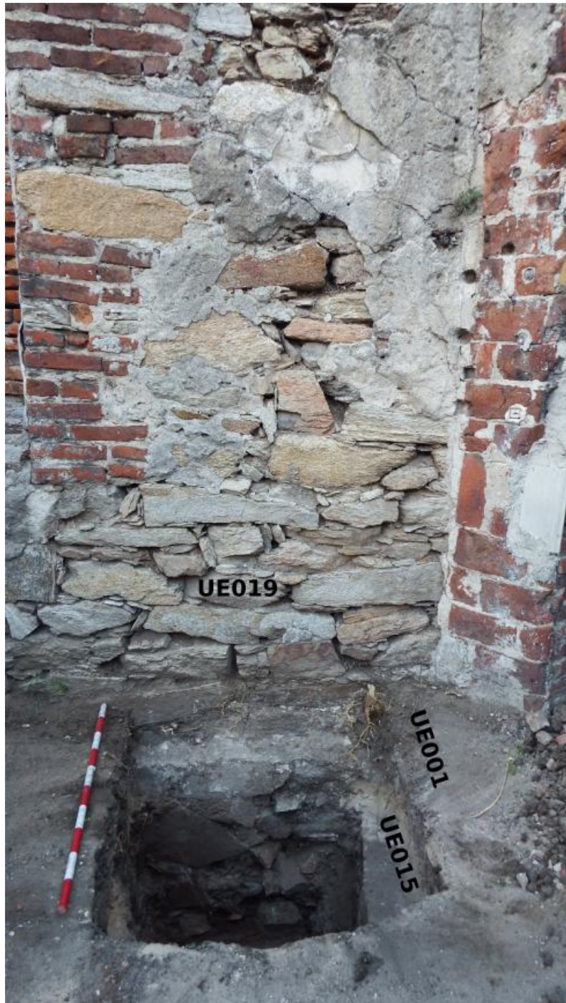
Figura 35. Sondeo 3. Vista panorámica del sondeo
