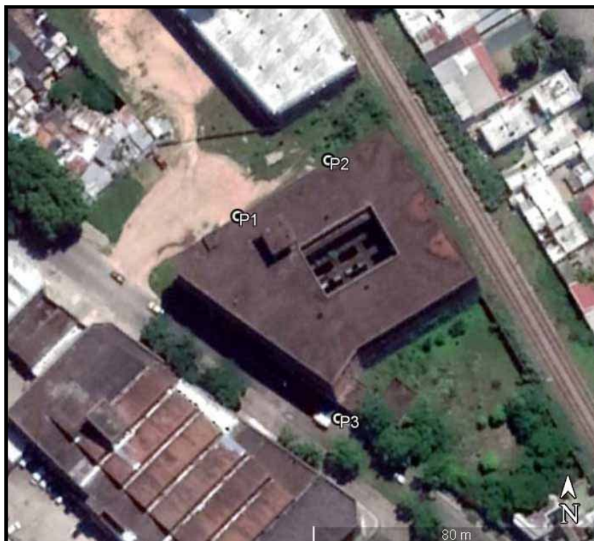
Figura 2. Ubicación de las Perforaciones
