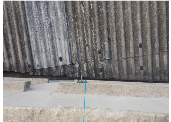
Línea de vida a desinstalar
