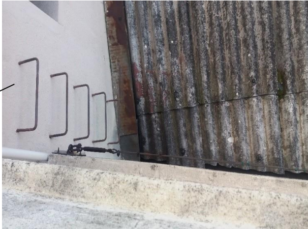
Instalación de anclaje para acceso a techo
