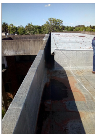
FOTO 9 – Azotea no transitable a impermeabilizar y con pretil a completar (dejando canalón existente bajo tramo superior de techo de paneles).
