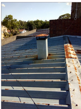
FOTO 5 – Cumbreera sobretecho a dos aguas.
