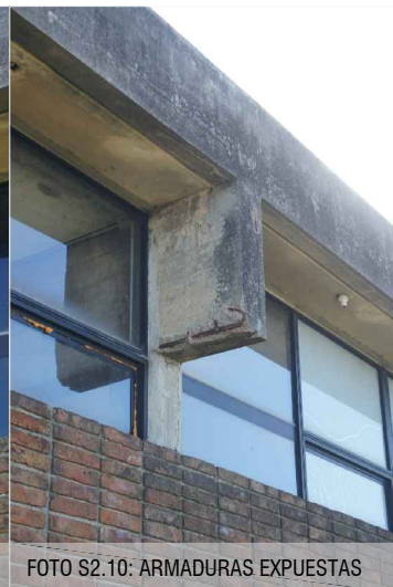
FOTO S2.11: ARMADURAS EXPUESTAS
