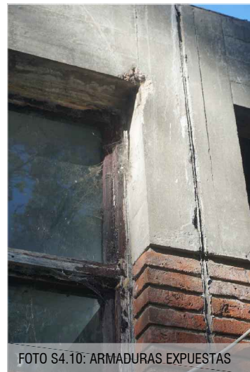
FOTO S4.11: ARMADURAS EXPUESTAS
