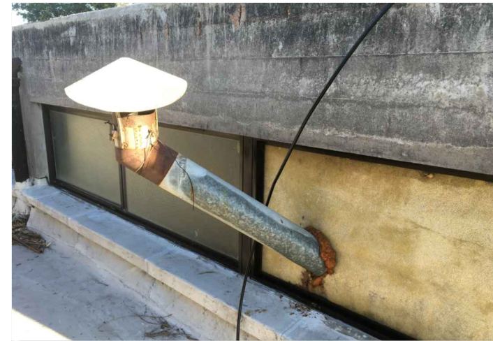
FOTO S3.03: CHIMENEA
