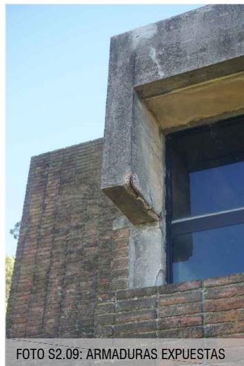
FOTO S2.10: ARMADURAS EXPUESTAS
