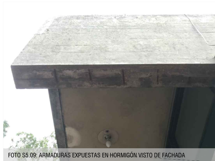
FOTO S5.06: ARMADURAS EXPUESTAS EN HORMIGÓN VISTO DE FACHADA
