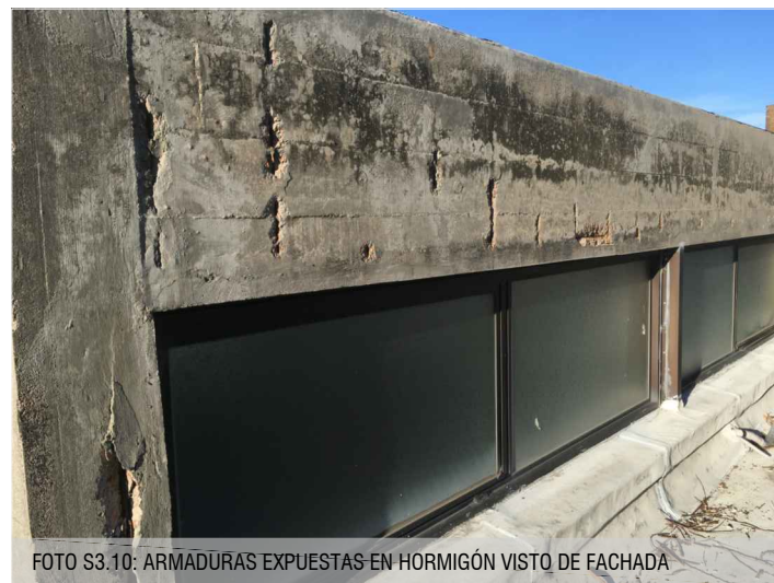
FOTO S3.11: ARMADURAS EXPUESTAS
