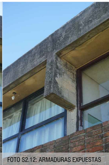
FOTO S2.13: ARMADURAS EXPUESTAS
