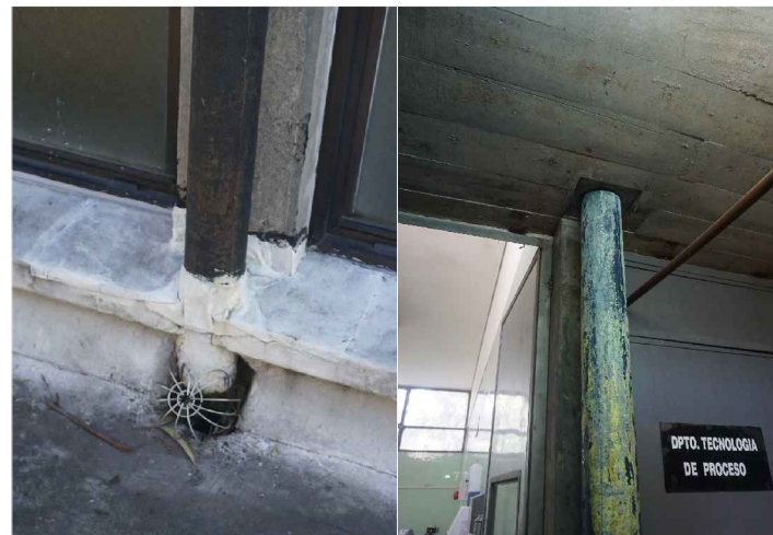
FOTO S3.02: BAJADA DE PLUVIALES S3.3
