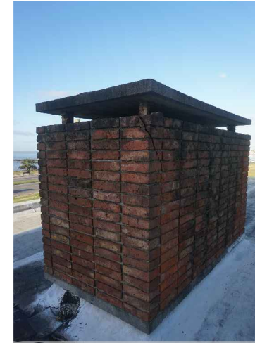
FOTO S1.05: CHIMENEA DE LADRILLO
