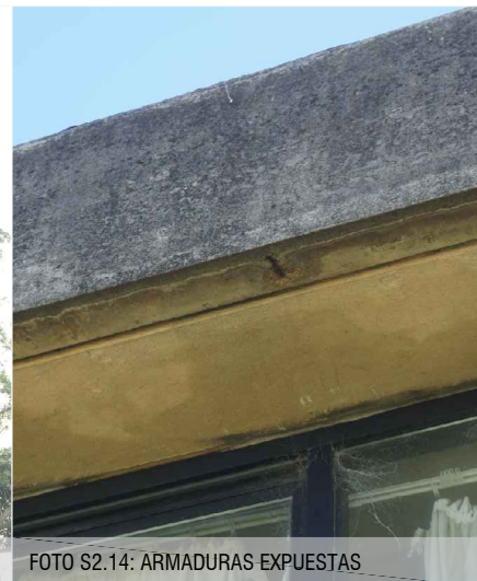
FOTO S2.13: ARMADURAS EXPUESTAS
