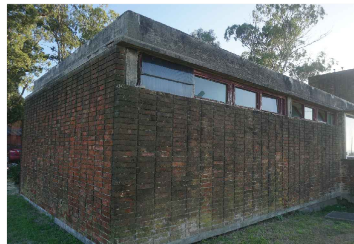
FOTO S1.13: ABERTURAS EN MAL ESTADO A REEMPLAZAR Y HORMIGONES A REPARAR
