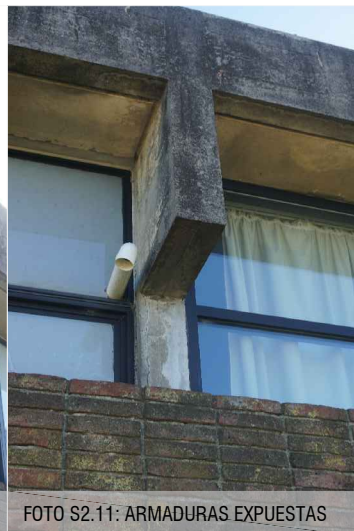
FOTO S2.12: ARMADURAS EXPUESTAS
