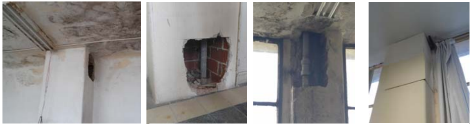
Situación actual de ambos ductos
