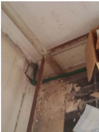
Punto de unión entre tramo nuevo y tramo existente
