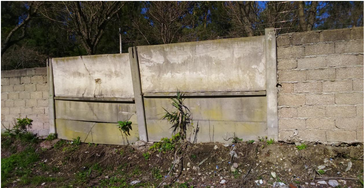
Img.01. Condiciones del Muro actual, en tramo a ser sustituido.
